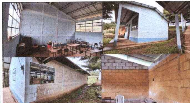
Foto 3: Repello y pintura, de interior y exterior.
