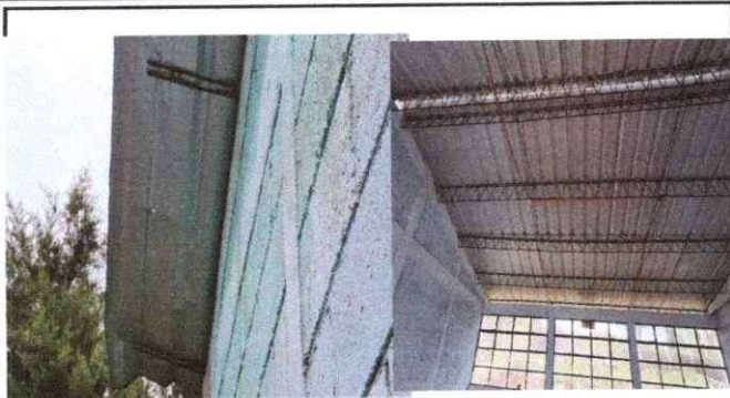
Foto1: sustitucion de laminas dañadas y cambio de estructura de techo ,aula 3
